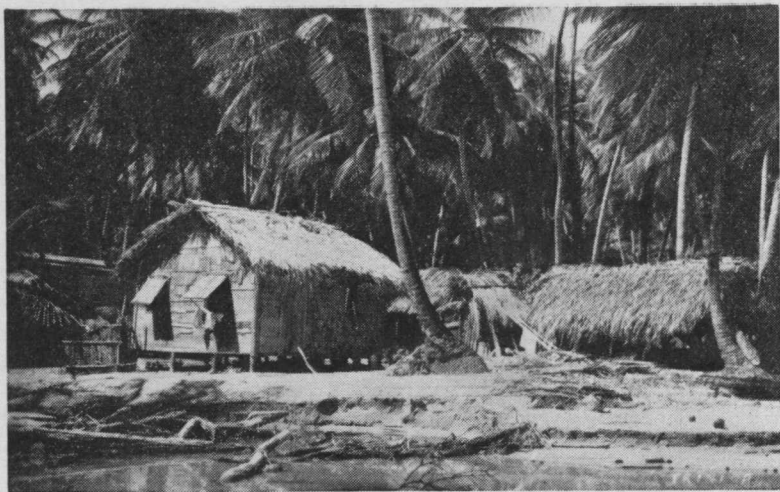
Trinidad salos gyventojų lūšnelės
